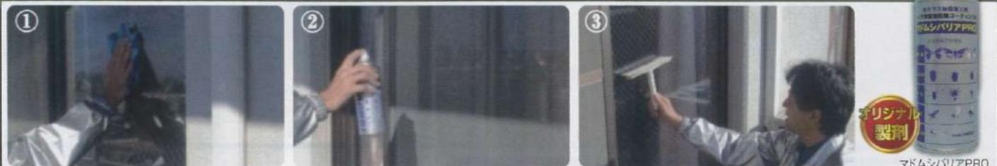
使用方法 ①噴霧対象ガラス面を清掃してください。②ノズルを噴霧箇所に向け、30cm程度離して、均一に濡れる程度噴霧します。③スポンジ等でムラなく均一に塗布してください。
